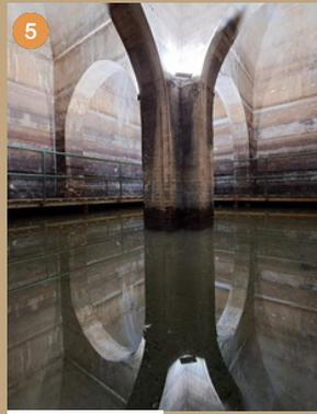
Depósito para conservar el agua de la lluvia, con una claraboya en el centro que permite la recogida de agua, construido entre el S.XI- XIII
